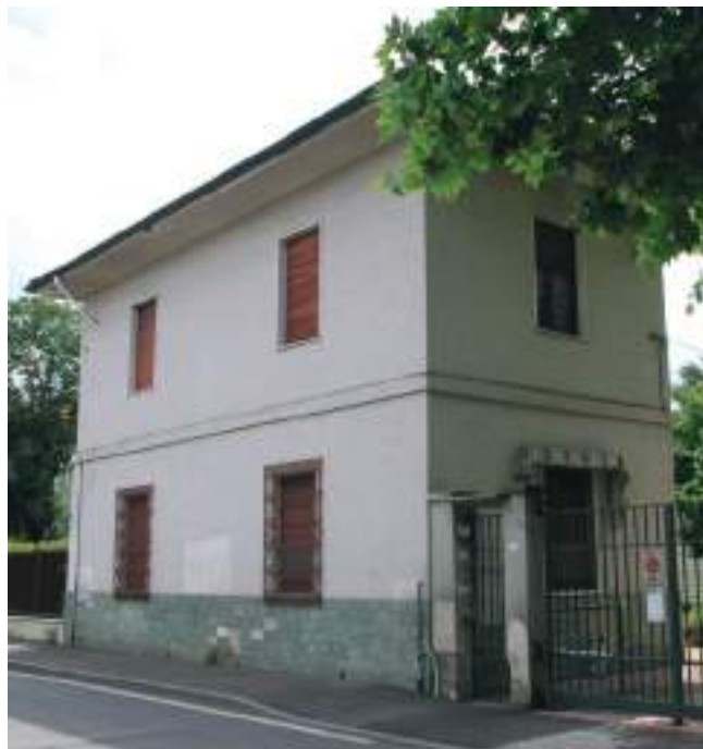
La casa di via Biraghi in attesa di ristrutturazione
